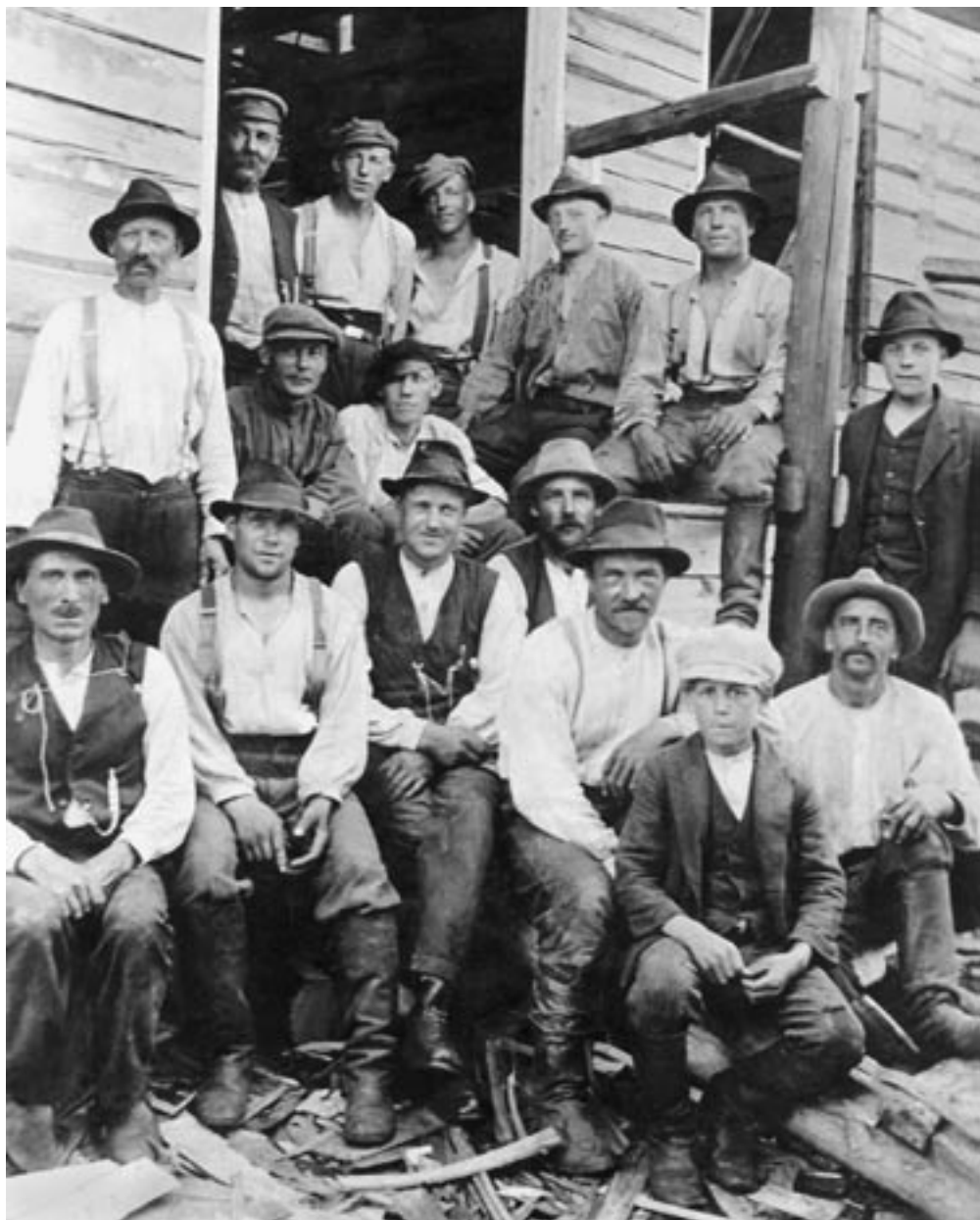
Puustellin rakentamisen urakoinut rakennusmestari August Kallio ylinä vasemmalla. Vieressä hänen poikansa Alekski ja Niilo. Alhaalla oikealla istumassa Jalmari Salo, vasemmalla kolmas Frans Aaltonen ja hänestä vasemmalla Aarne Tuominen. Istumassa ylhäällä tolpan vieressä Artturi Tuominen. Vasemmalla seinän vieressä seisomassa August Ikonen ja aivan edessä istumassa on hänen poikansa. Kuva Yrjö Louhi.
